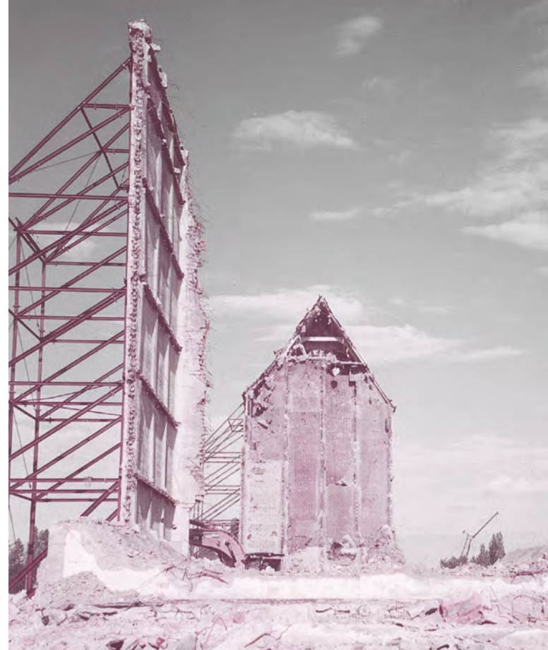
Ausbau der Speicher auf der Silohalbinsel (2000)
